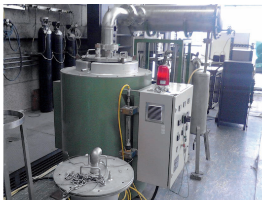
Planta piloto de pirólisis para el tratamiento de residuos Pyrolysis pilot plant for waste treatment
